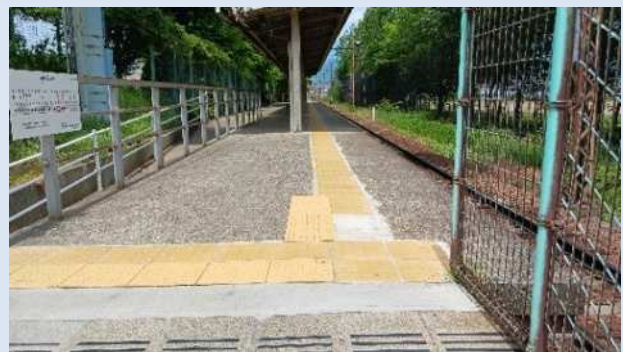
【内方線付点状ブロックが敷設されたホーム】
