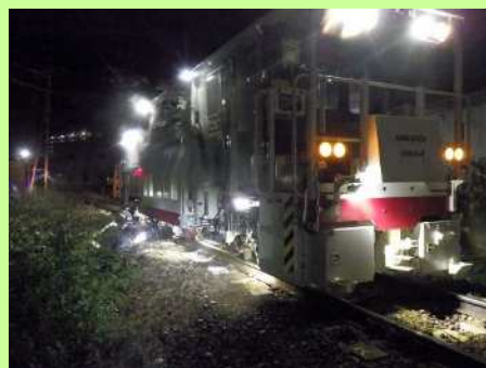
【夜間に行われる軌道整備作業】
