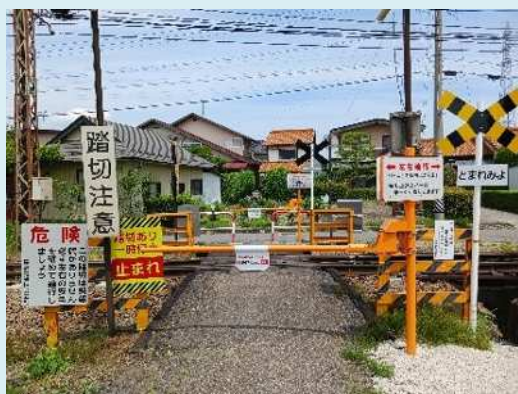
【ゲートを設置した踏切道】
