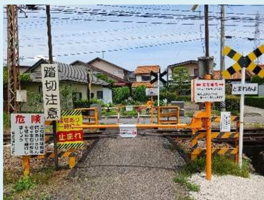
【ゲートを設置した踏切道】
