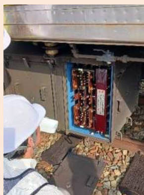
【床下機器の確認】
