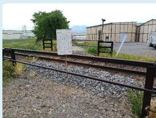
【廃止となった第4種踏切】
