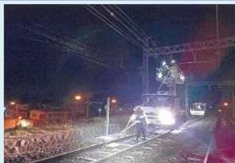
列車を動かすために電力を送るトロッコ線（電線）が摩耗した場合は、断線に繋がる恐れがあることから、定期的に更新工事を行い、安全運行の向上を図りました。
