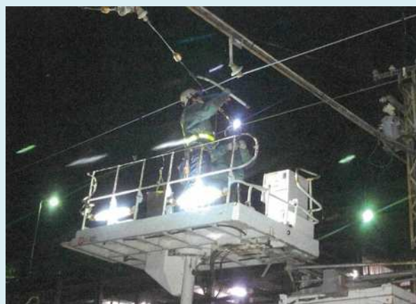
【トロリ線交換作業】
