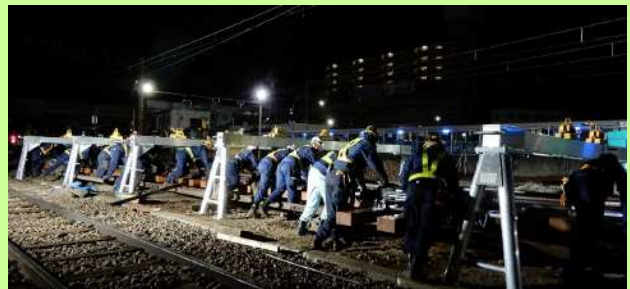
【夜間に行われるレール交換作業】
