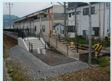
【北須坂駅に新設された階段】
