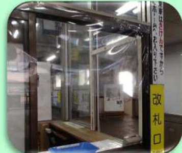
【飛沫防止スクリーンの設置】
