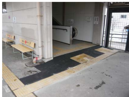
信濃吉田駅 ホームの段差解消
