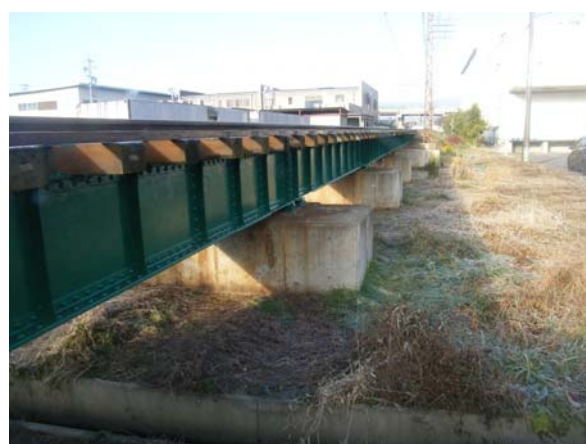
長野線 高梨橋梁改修工事
